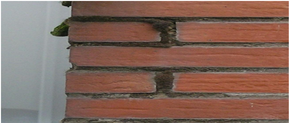
Figur 3.3 murverk vars angripen av biologisk tillväxt. ( Hoger Akram & Alan Hamid, 2010 )
