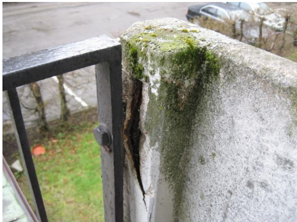
Figur 3.1 rostiga armeringen bildat sprickor i betong. ( Hoger Akram & Alan Hamid, 2010 )
