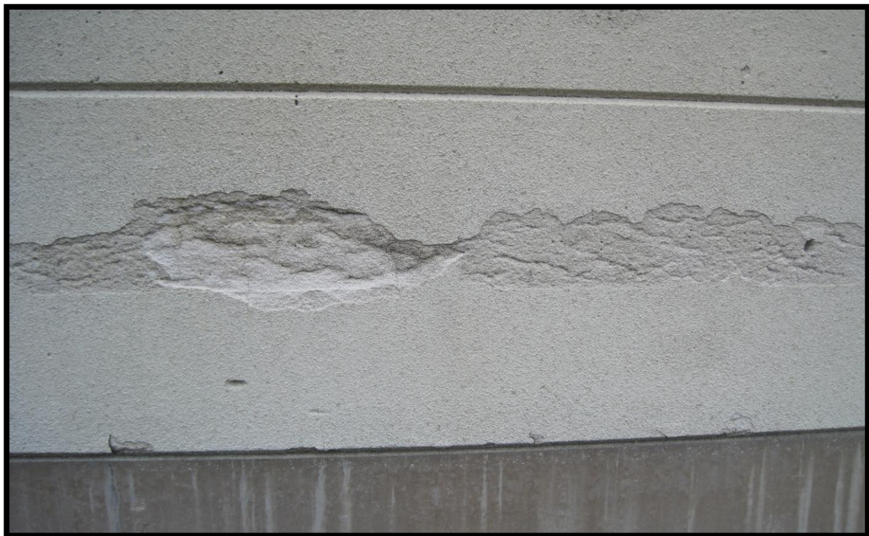
Bild.4. Ellos lagerbyggnad lättbetong oimpregnerad fasad. ( Hoger Akram & Alan Hamid, 2010 )
