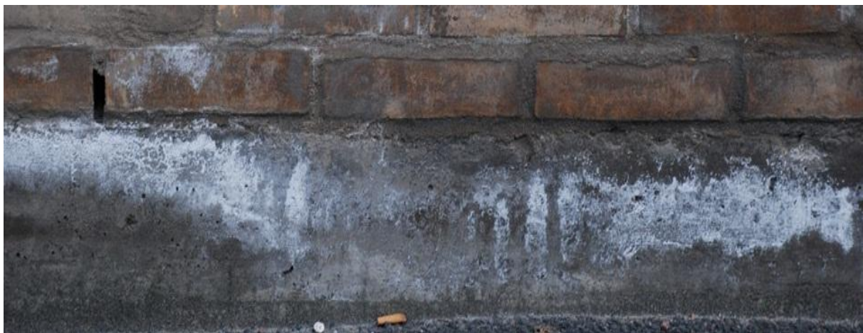
Fig. 3.4 saltutfällning i betongs under skulmur av tegel. ( http://www.nsiab.com/datablad/c2/C2_info_4sid.pdf , 2010)
