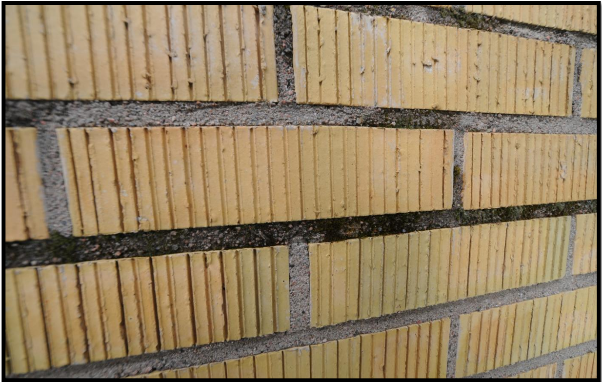
Bild.7. murverk vars angripen av biologisk tillväxt. ( Hoger Akram & Alan Hamid, 2010 )
