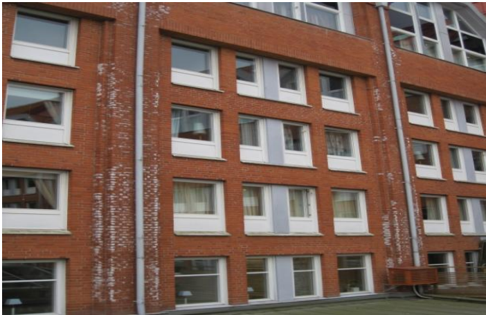
Figur 4.3 . utfällning av (salt eller siloxan). ( Hoger Akram & Alan Hamid, 2010 )
