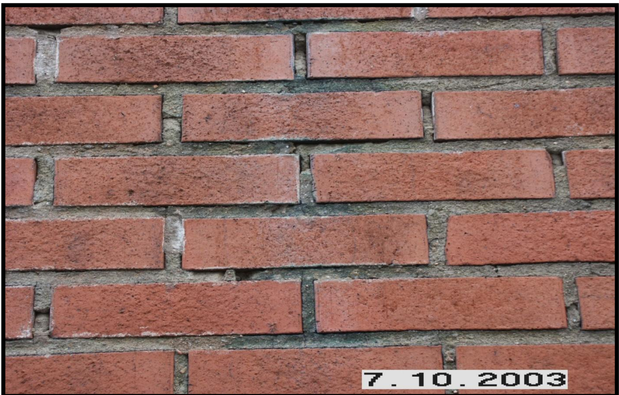
Bild.6. saltutfällning, felaktig foglagning. ( Nsiab , 2003)
