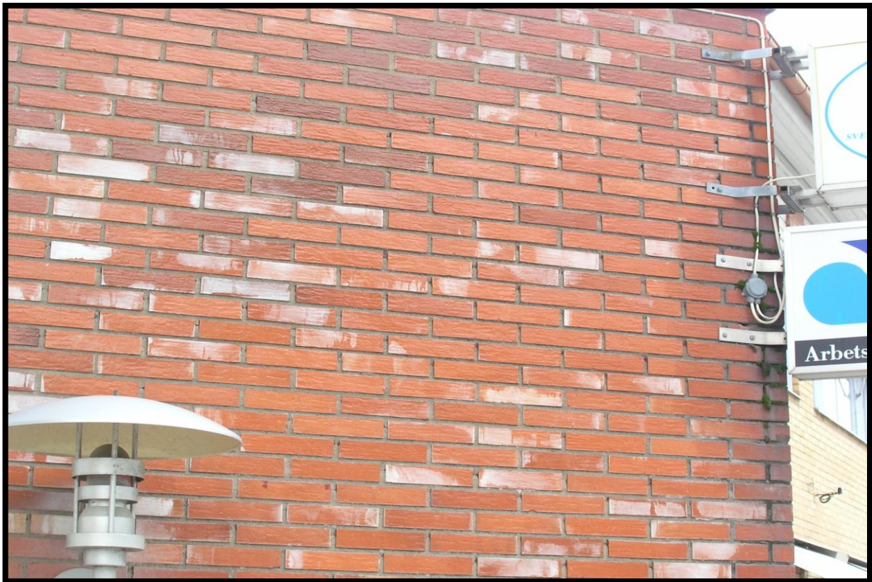
Bild.9. fukt skada (saltutfällning & biologisk tillväxt). ( Hoger Akram & Alan Hamid, 2010 )
