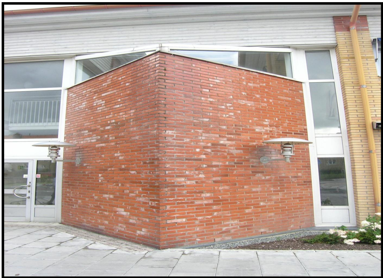
Bild.10. fukt skada på en siloxan behandlad vägg. ( Hoger Akram & Alan Hamid, 2010 )
