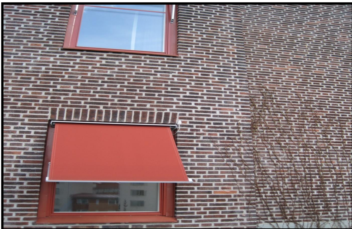
Bild.2. Eriksbergskontoret efter renovering med Kalkstark ® och impregnerad med stenimpregnering C2 ® . ( Hoger Akram & Alan Hamid , 2010)
