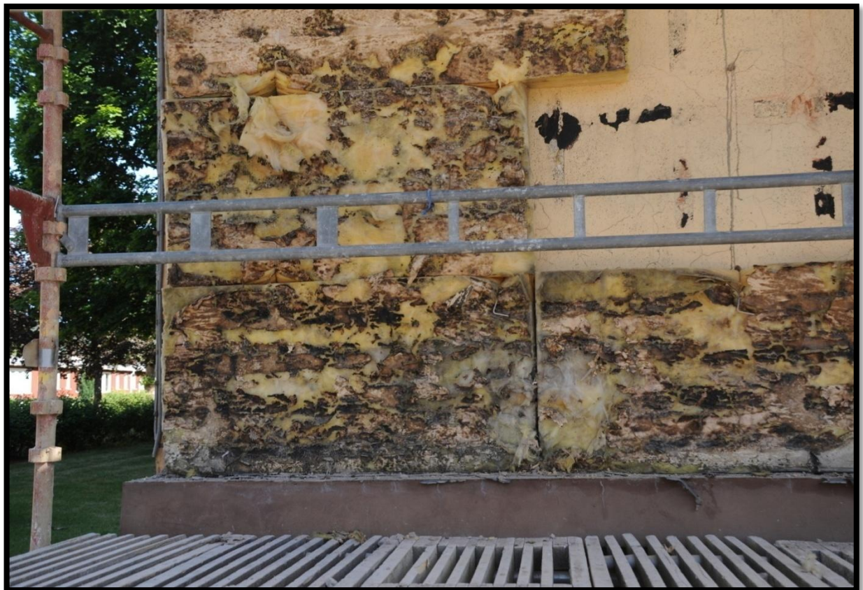
Bild.8. fukt skada. ( Nsiab, 2008 )
