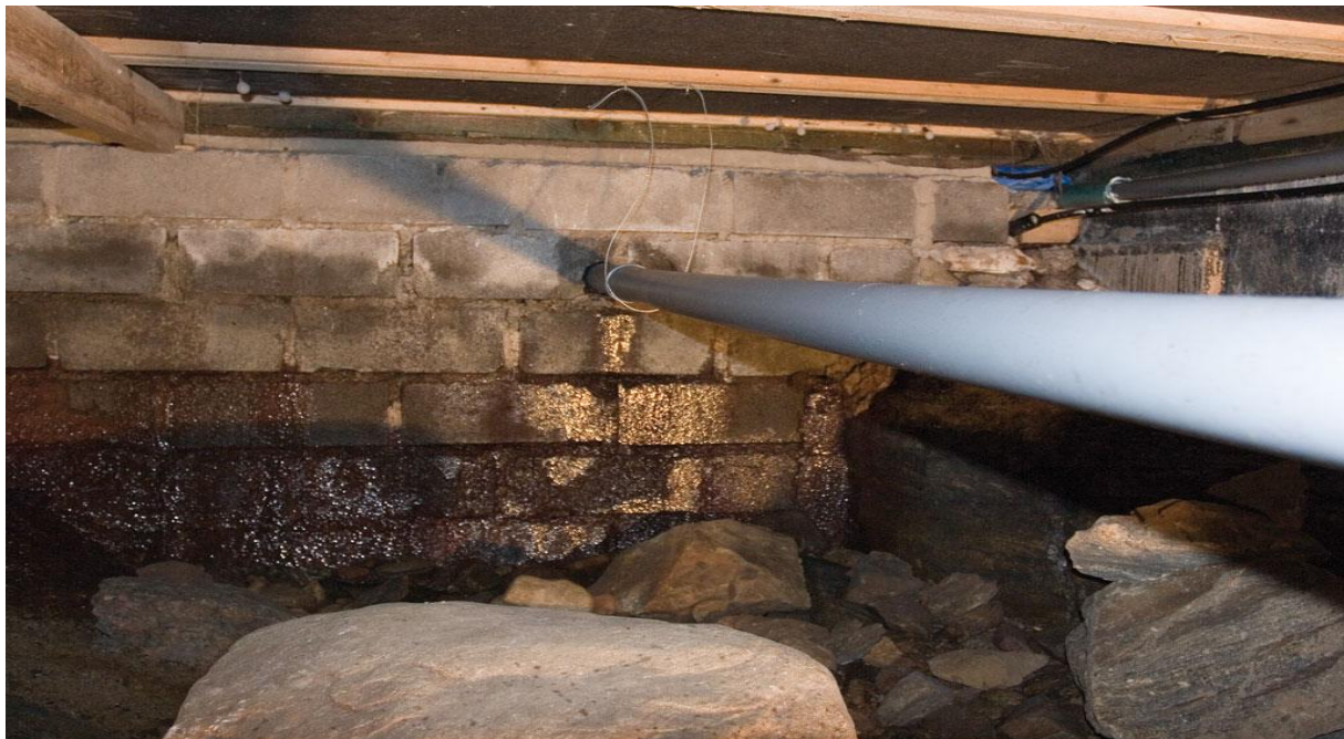
Figur 4.5 fukt i grund.
